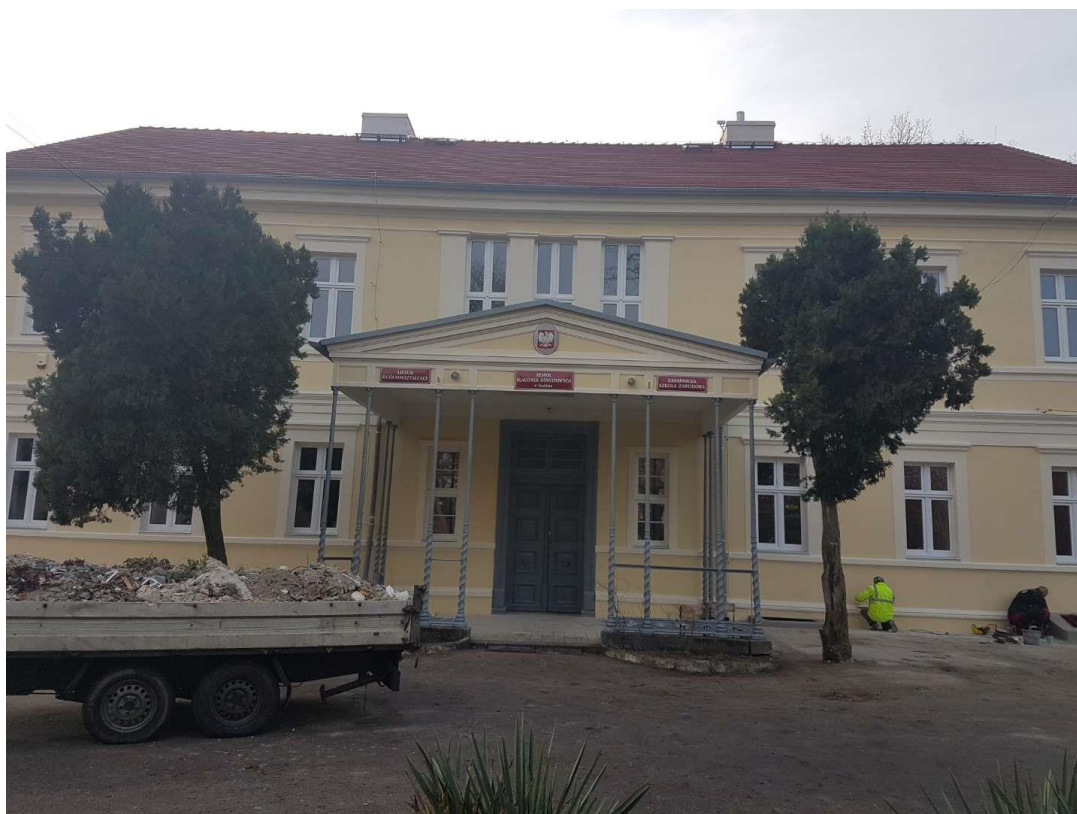
Prace remontowe budynku dobiegają końca
